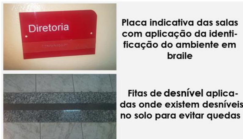
Figura 5 - Exemplos de placa indicativa e faixa tátil de piso indicadora de desníveis
