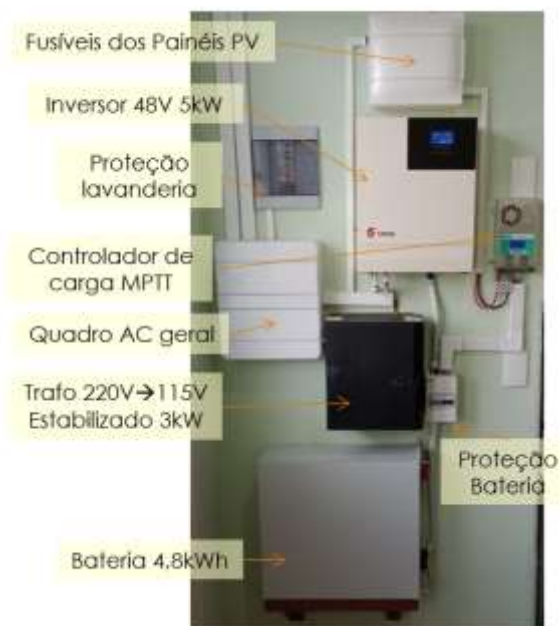
Figura 2: Componentes do sistema fotovoltaico
